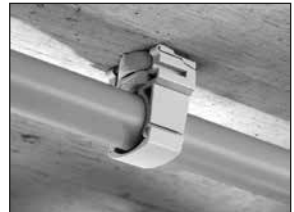
Cable conduits or light duty pipes
